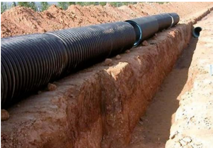
Possibilità di preassemblaggio fuori scavo, in condizioni di maggiore comodità, pulizia e sicurezza
